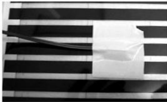
11 Крепление датчика температуры пола
