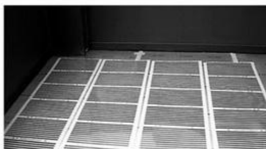
6 На теплоизоляционный материал настилается нагревательная пленка
