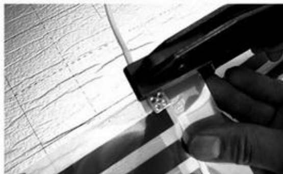
7 Подсоединение провода к нагревательной пленке
